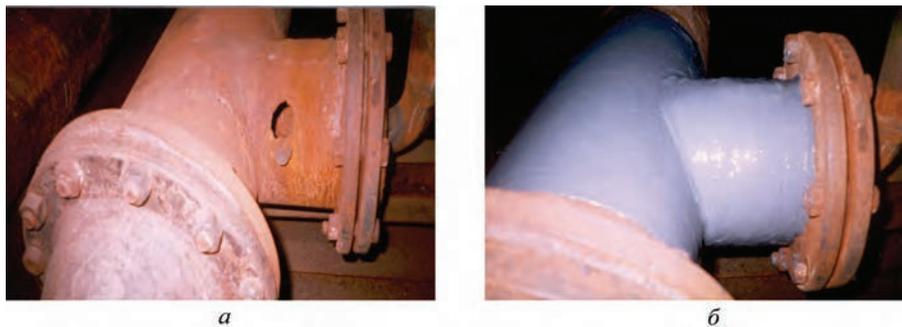
Рис. 5. Восстановленный узел бойлера на ФГУП «ВМЗ»: а – до восстановления; б – после восстановления
