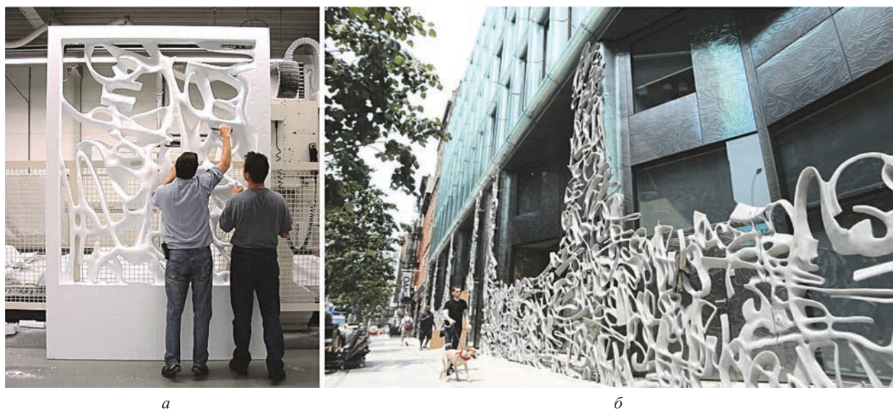
Рис. 2. Художественное литье – архитектурное украшение жилого здания: а – модель ворот; б – секции алюминиевых отливок коллажа в сборе вдоль крупного здания Нью-Йорка [4]
