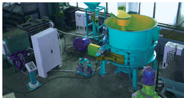
Рис. 5. Отладка автоматизированного смесеприготовительного комплекса мод. 4847
