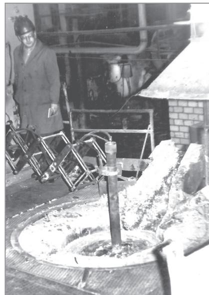
Рис. 2. Плазменная установка для рафинирования в работе
